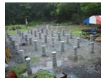
基礎工事(外注)
