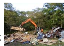
旧ヒュッテ解体工事
