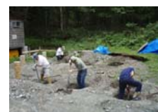
炊事棟基礎穴掘り
