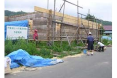
仮組作業(沼ノ沢)
