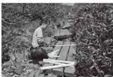
木道にスリッパ止めを取付ける
