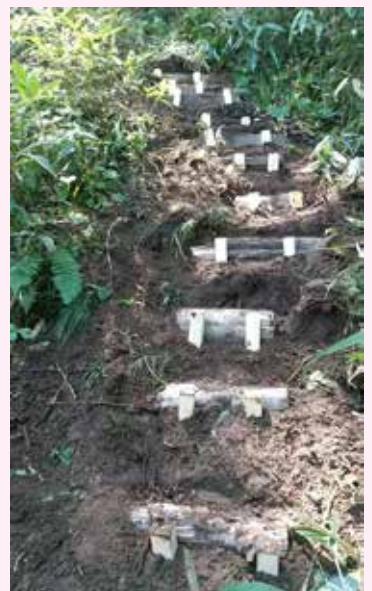
滑る粘土質斜面に階段を作る
