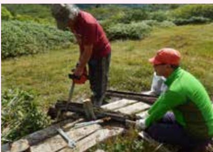
運びやすい大きさと重さに切りそろえる（チェーンソーでの作業）
