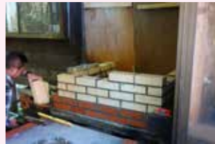
炊事棟の暖炉工事 風呂の煙突との接続も兼ねて工事を進めています。
