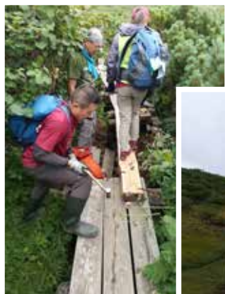
前後の木道に固定して橋渡しする
