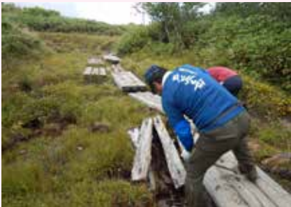
掘り起こし作業は順調に進んだ
