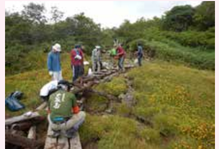
付近の植生に気を使いながら作業する
