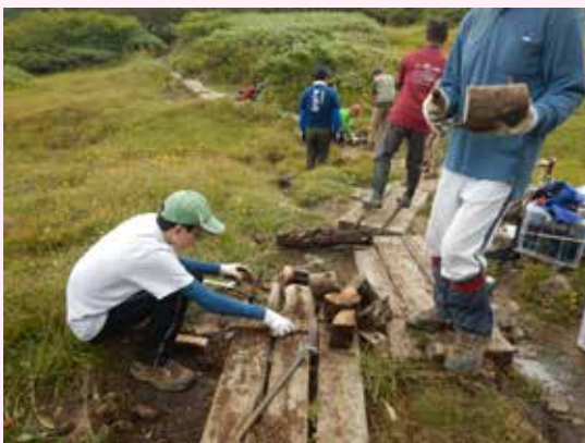
昨年の木道撤去・整理の様子。総勢13名で該当木道の撤去&移設&解体作業を行いました。1年経ちましたが、撤去後の跡には水が流れ、完全ではありませんが現場は徐々にまた昔の湿原の姿に戻ろうとしているようです。
