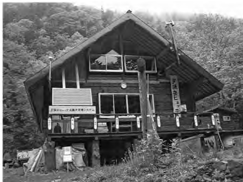
ソーラーパネル設置
