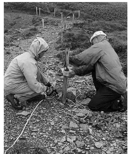
登山道巡視 コースロープ補修作業 2012.9月
