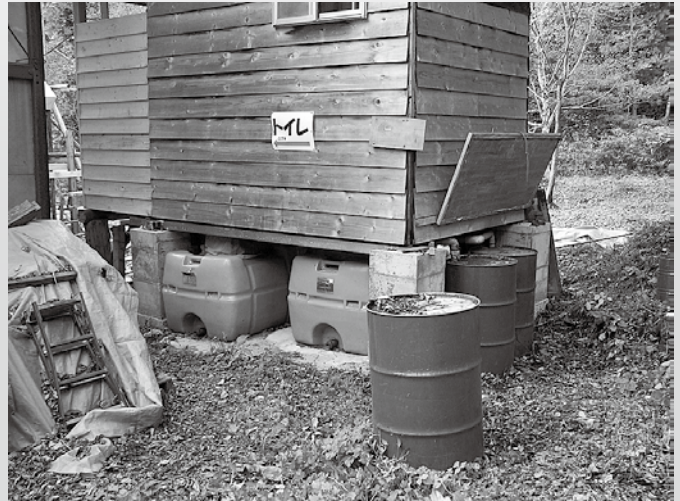
ヒュッテトイレ汲み取り作業 4回目
