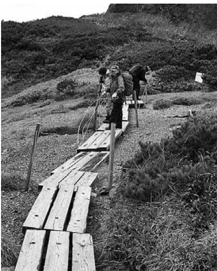
崩壊地コースロープ撤収作業 2012.10月
