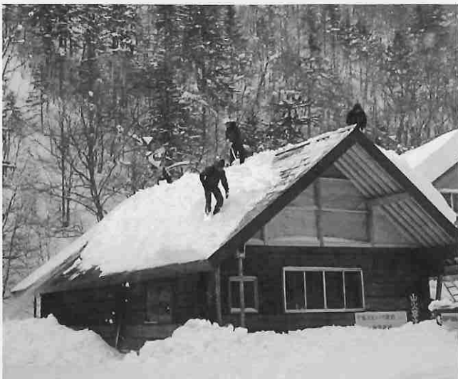
新ヒュツテ雪下ろし作業
