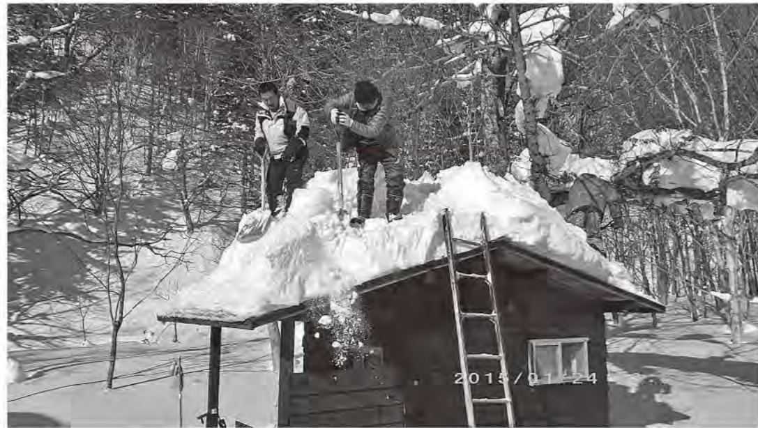
トイレ棟の雪下し
