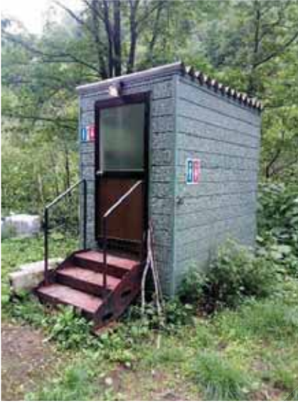
駐車場にあるトイレ
