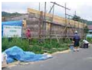
仮組作業（沼ノ沢）
