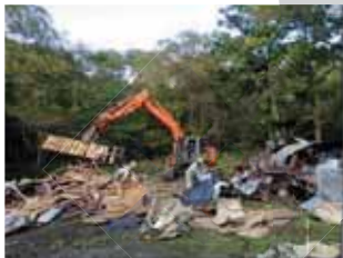
旧ヒュッテ解体工事
