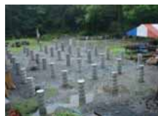
基礎工事（外注）
