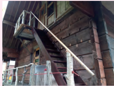
ヒュッテ北側についた非常用の階段と、1階のテラス。
