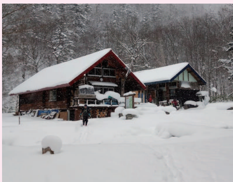
昨年末の夕張岳ヒュッテの様子。例年であれば1メートル位の積雪がある時期ですが、おおよそ半分以下の積雪状況です。今年は水道設備新規引き直しや、レンガを使った工事を予定しています。
