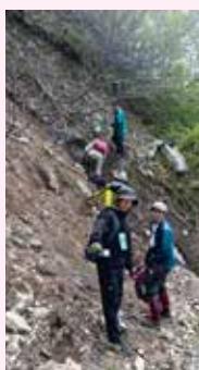
崩落箇所の応急措置
